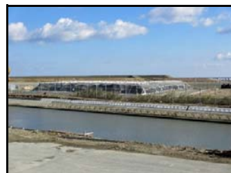
土のう設置状況
