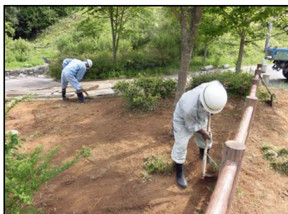
除染作業状況(公園施設)
