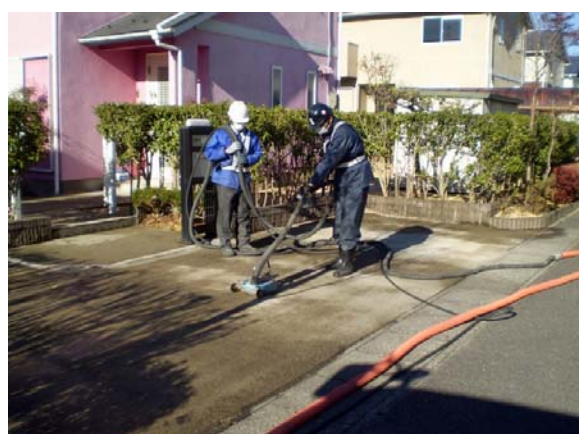
コンクリート洗浄作業
