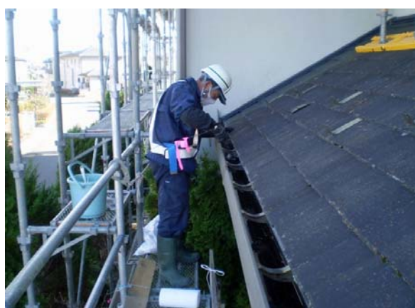
雨樋の除染作業
