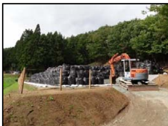
通気性防水シートキャッピング前
