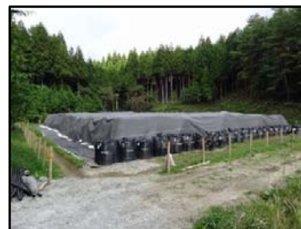
キャッピング完了後
