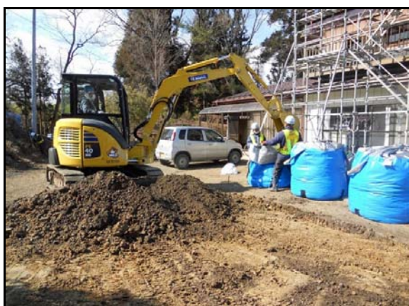
地表面の除染及び汚染土の袋詰め
