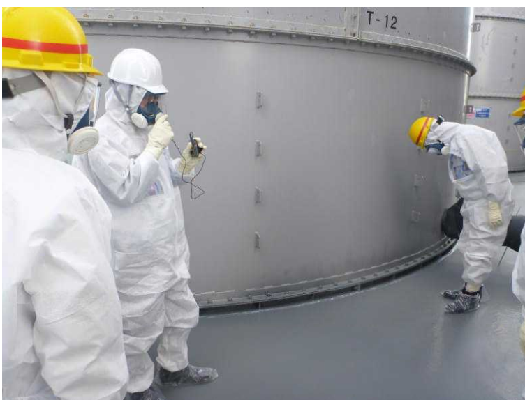
○現地確認 (G4タンクエリア) 堰内のウレタン塗装の施工状況の確認
