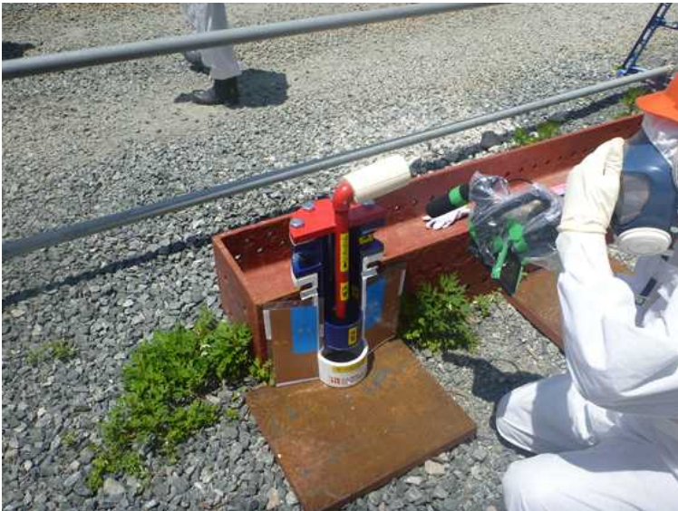
○凍土遮水壁実証試験 (凍結管模型)
