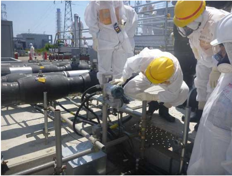
○地下水バイパス 放出流量確認風景
