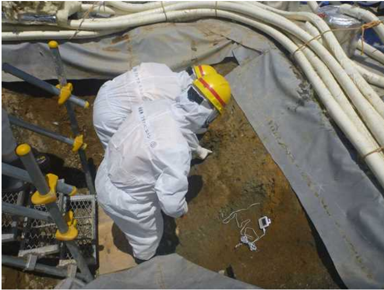
○凍土遮水壁実証試験 (遮水壁内側凍結状況確認)
