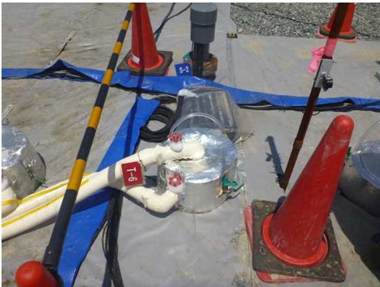
○凍土遮水壁実証試験 (凍結管)
