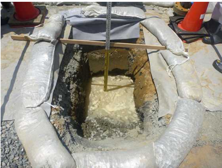
○凍土遮水壁実証試験 (遮水壁外側地下水位)
