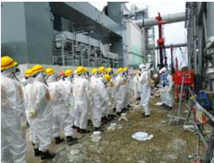
○凍土遮水壁工事現場の 確認 4号機R/B南付近 (8BLK)
