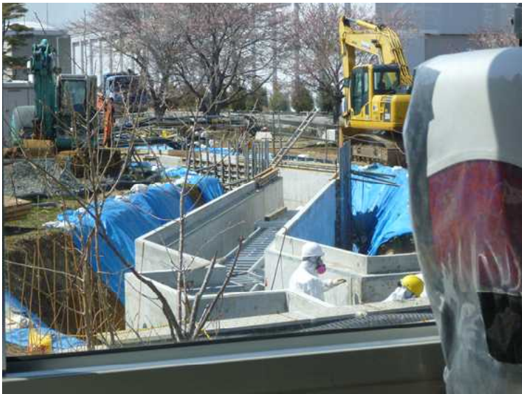
○ B・C排水路付け替え 排水路の排水口の状況確認
