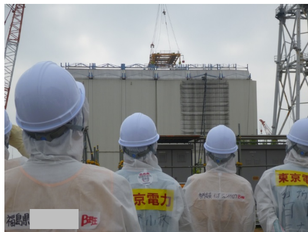
吊上治具を屋根パネル上部に移動している様子
