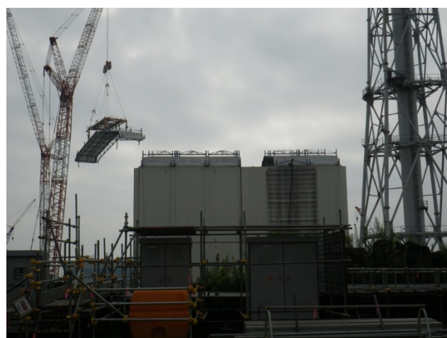
屋根パネル吊り上げの様子
