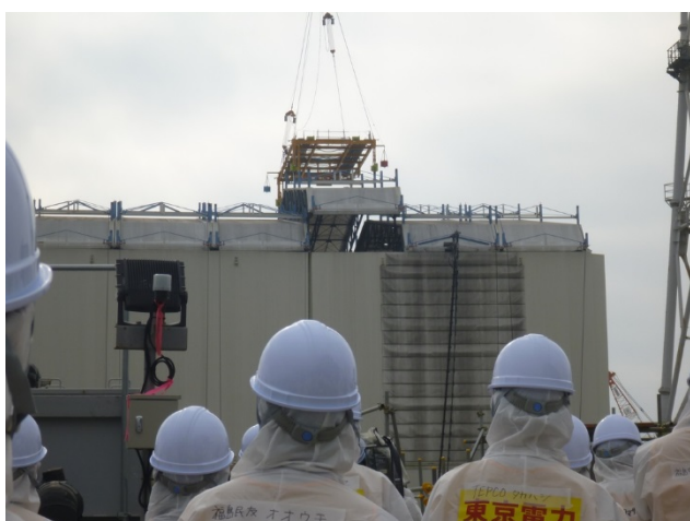
屋根パネル吊り上げの様子
