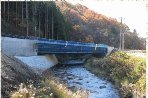
①(仮称)1号橋
