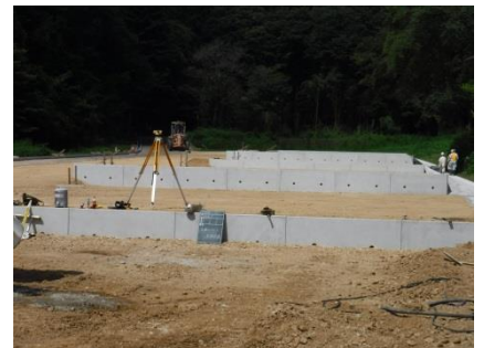
宅地の整地工事
