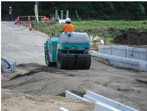
道路の路盤工事
