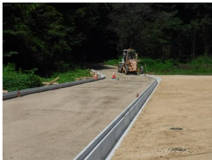
道路の路盤工事
