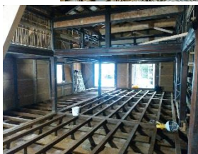
→土屋根施工時
