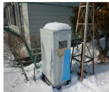
飯館村長泥コミュニティセンター の可搬型モニタリングポスト (平成24年1月26日撮影)
