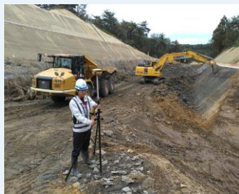
〈ICT建機を利用した施工状況〉
