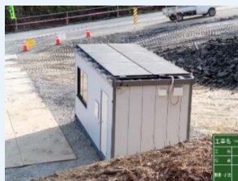
〈工事現場事務所へのソーラーパネル設置〉
