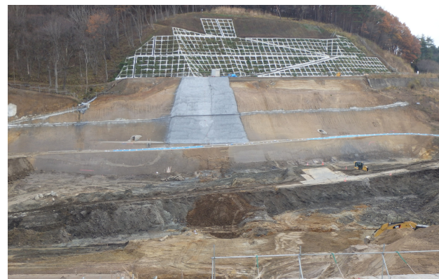
現在、本堤は掘削作業を、副堤は盛土作業を進めています。
