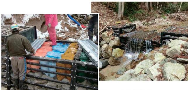
写真5-2 吸着材を使用した濁水防止工
