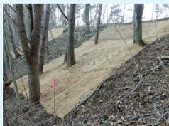
ヤシ・ジュート製のマット。1枚の大きさは1m×3m。10cm間隔で種子、肥料等の入った植生基材袋を装着。最大厚5cm/枚。
