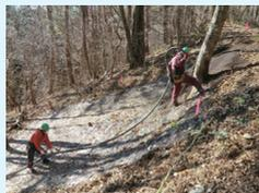
パーク堆肥、肥料、接合剤、種子を混合したものをを用い、ラス（金網）張の後、コンプレッサーで高圧をかけ吹付。
