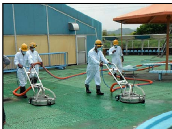
同時吸引型高圧洗浄実施
