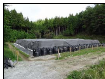
キャッピング完了後
