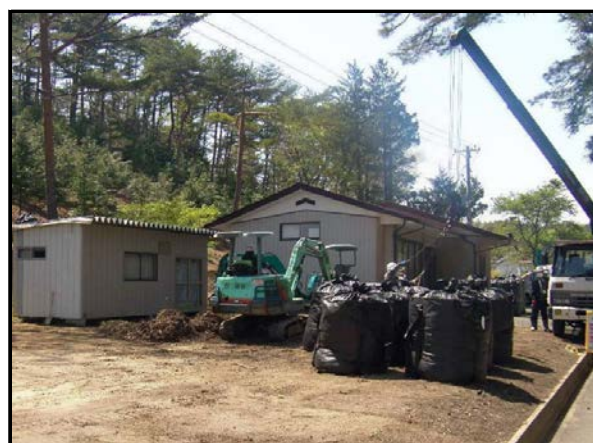
公共施設の除染状況(フレコン運搬)
