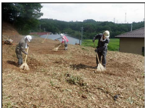
森林(生活圏)の除染状況(堆積物除去)
