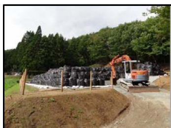
通気性防水シートキャッピング前
