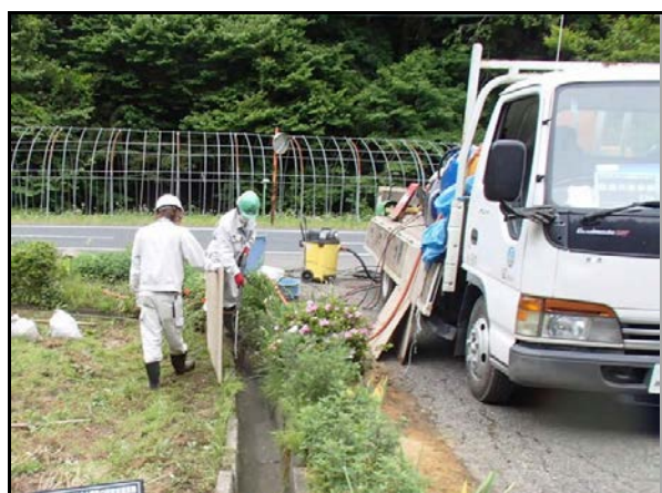
側溝除染作業中
