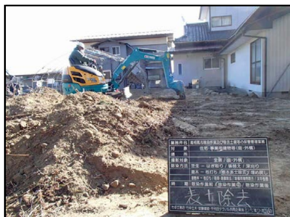
庭除染作業中
