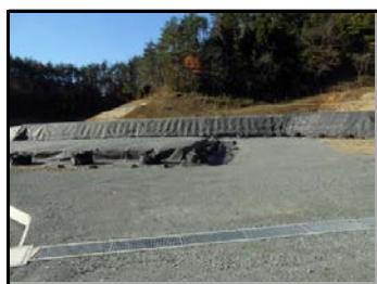
仮置場保管状況
