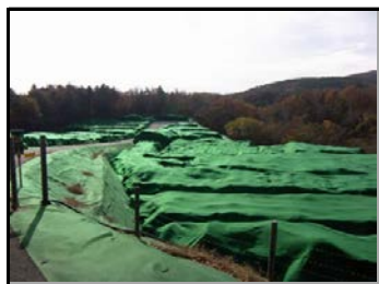
大津辺仮置場
