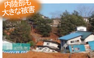
家屋被害の状況（福島市伏拝地区内）
