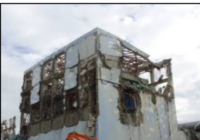
ガレキ撤去前 (撮影日：平成23年9月22日)
