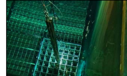
共用プールへの格納(変形燃料) (平成26年11月4日撮影)
