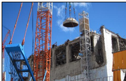
圧力容器上蓋の撤去 (撮影日：平成24年9月13日)
