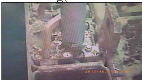
燃料ラック上部ガレキ吸引作業 (撮影日：平成25年10月11日)
