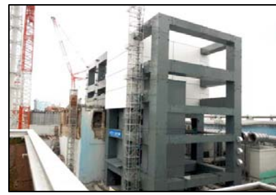
鉄骨建方完了 (撮影日：平成25年5月29日)
