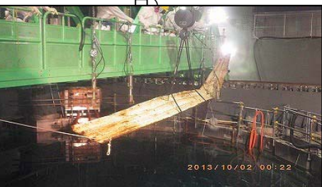
大型ガレキの撤去 (撮影日：平成25年10月2日)
