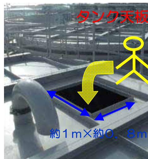
タンク天板部
