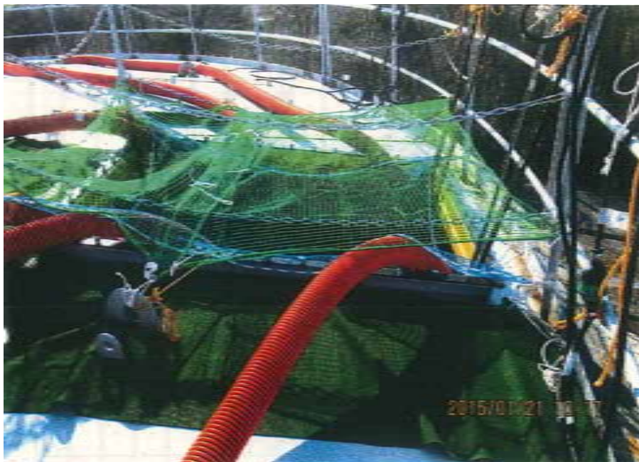
ハッチ開口部転落防止措置
