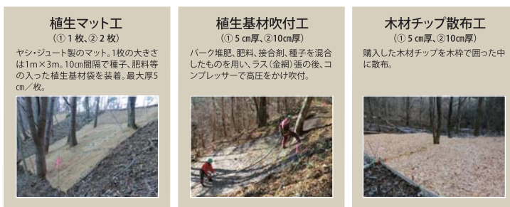
【写真1】林床の各被覆工
