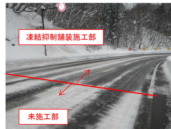
図2. 凍結抑制舗装の様子 国道289号東地内(H26年度施工)
