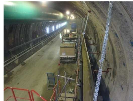
図3 ベルトコンベア設置状況
