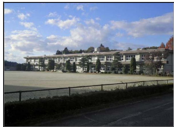
除染現場 (山白石小学校)
