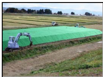
仮置場 設置工
