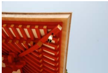
金堂屋根の軒先
