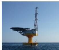
洋上変電所 「ふくしま絆」
