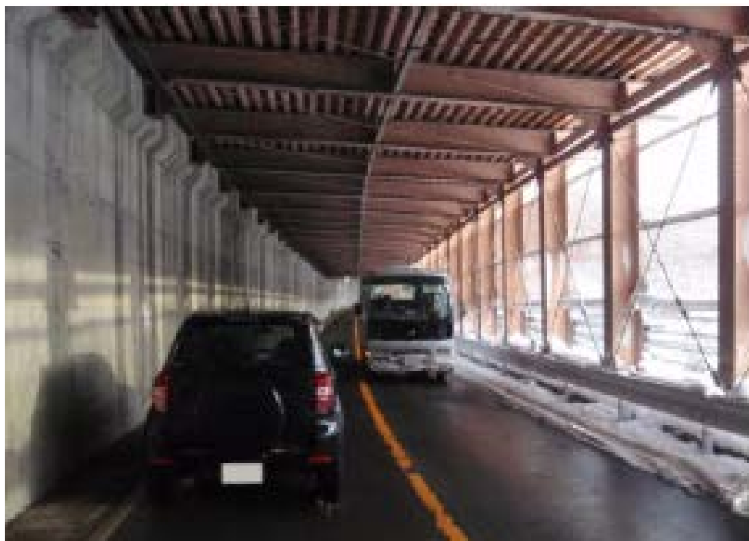
国道252号（金山町大字滝沢地内 滝スノーシェッド）
