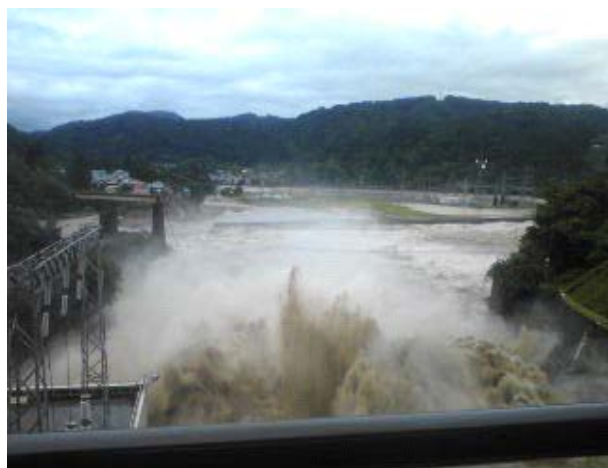
【写真1.2】 JR只見線 第6只見川橋梁流出
