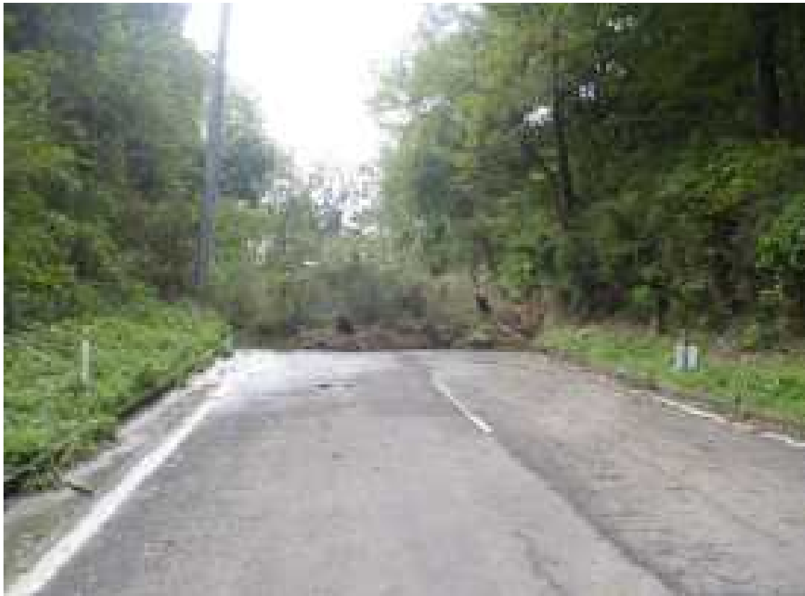
[4]主要地方道郡山矢吹線の被災状況(須賀川市大久保地内)
