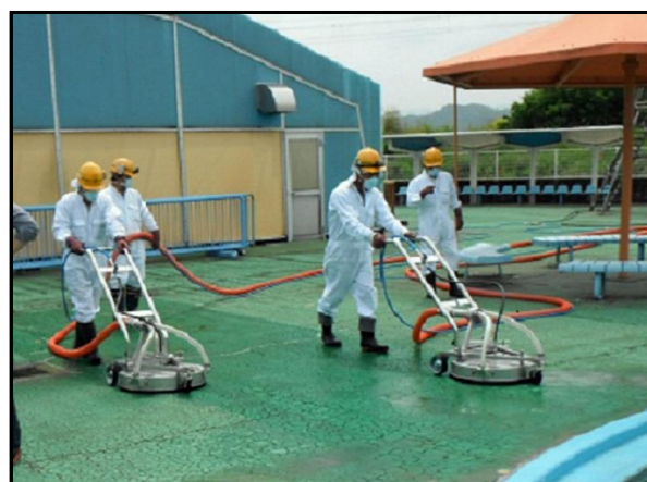
同時吸引型高圧洗浄実施
