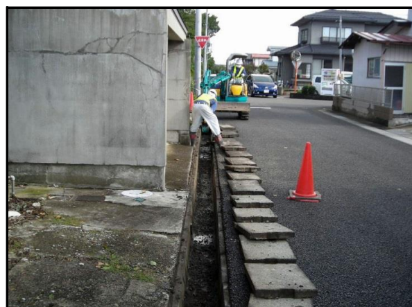
仁井田地区内側溝除染作業
