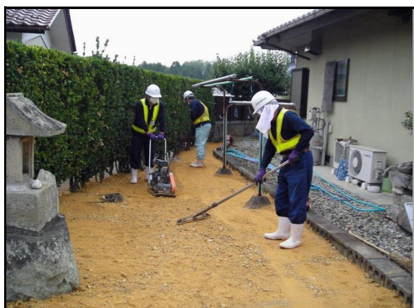
仁井田地区内住宅除染作業
