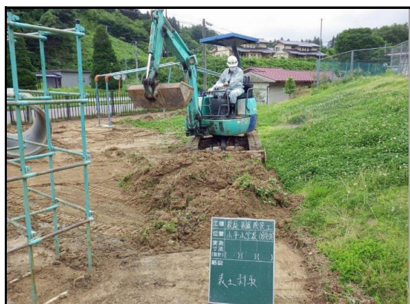
校庭除染工事表土剥取
