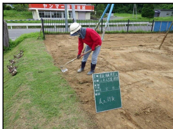
校庭除染工事表土剥取
