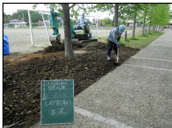
社川小学校除染状況
