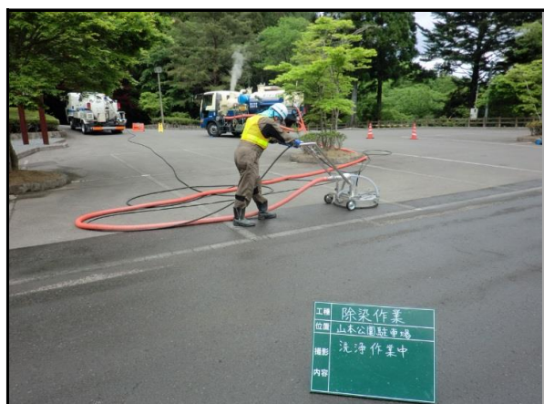
山本公園駐車場除染状況
