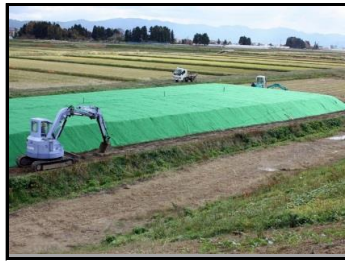
仮置場 設置工
