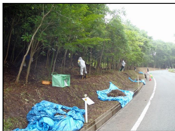
道路路肩除染作業 (H25当時)
