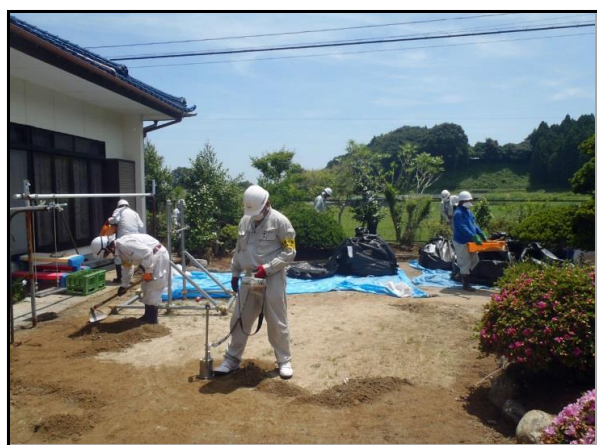
家屋除染作業 (H24当時)
