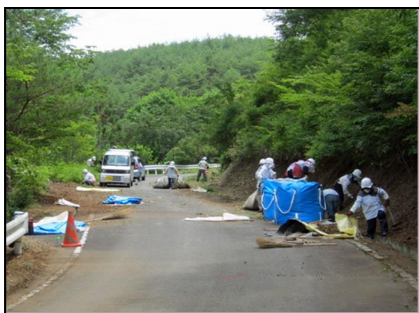
道路除染状況
