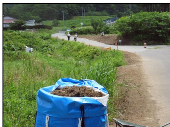
道路除染状況
