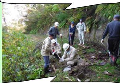
岩盤で杭も鉄筋も打設不可能。土留を石積工に変更しました。
