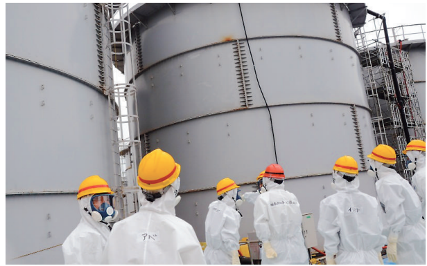
フランジ型タンクを視察する廃炉安全監視協議会
