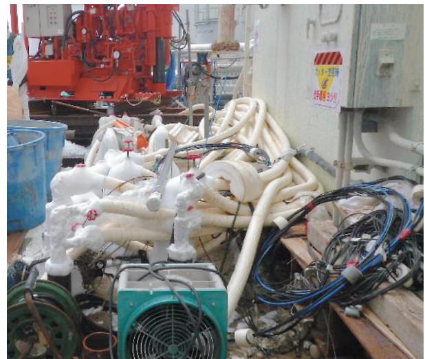
2号機海水配管トレンチ止水工事状況
