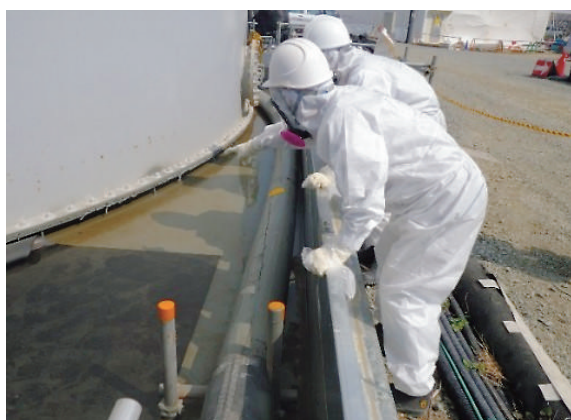
H6 タンクエリア堰内被覆状況確認
