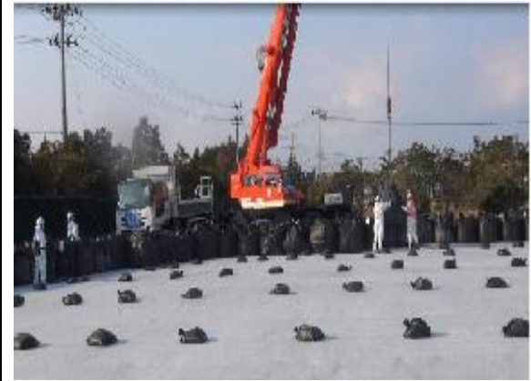
除去土壌の積下ろし作業
