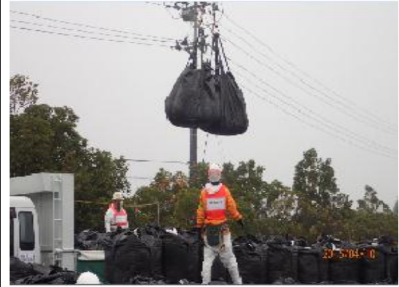
除去土壌の積下ろし作業
