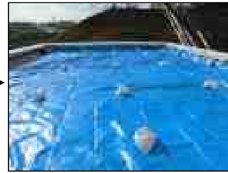
【写真②】 ブルーシート設置 (3月2日)
