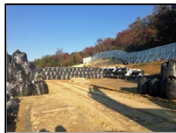
郡山市日和田町高倉地内の 仮置場整地作業
