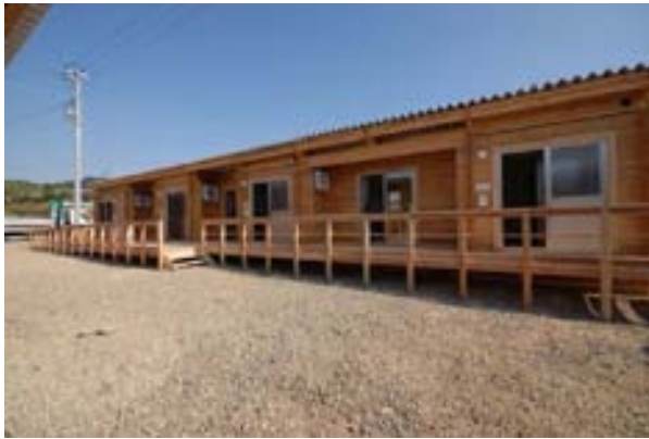
写真1 東日本大震災後にログハウスで建てた応急仮設住宅
