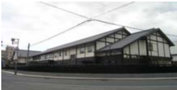
北西側より校舎を見る
