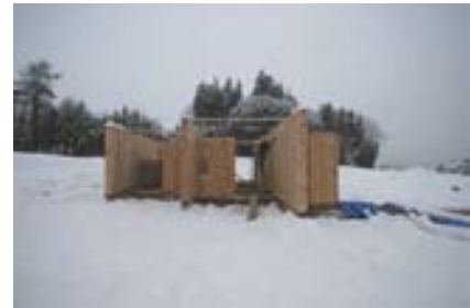
縦ログパネル建て方風景
