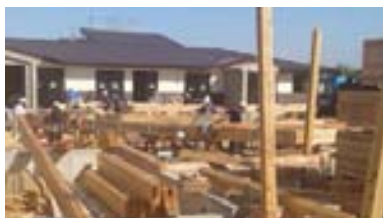
架構地組(奥には外観まで整い始めている北棟)
