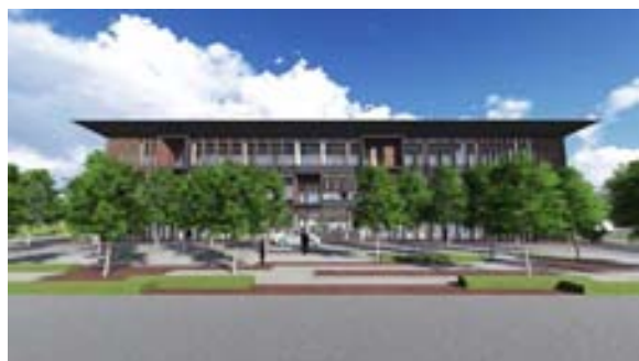
東側ファサード（庁舎正面）
