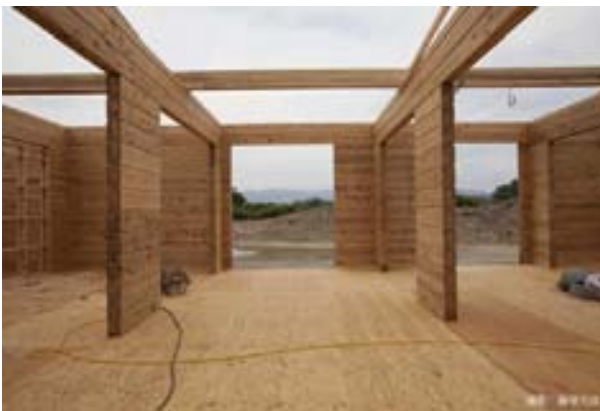
写真3 仮設住宅の施工中
