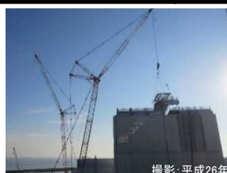
屋根パネルの取り外し
