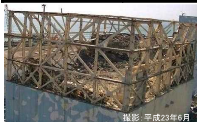
建屋カバー設置前の状況
