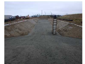
一時保管施設第3槽 施工状況
