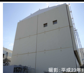
建屋カバーの設置状況
