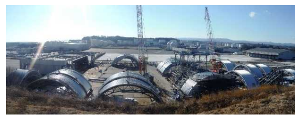
建屋カバーの製作状況(小名浜)
