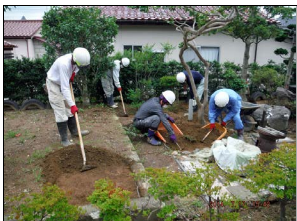
除染作業(表土除去作業)
