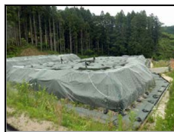
仮置場 搬入済み
