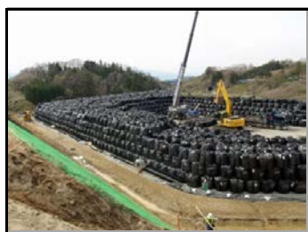
仮置場 搬入中
