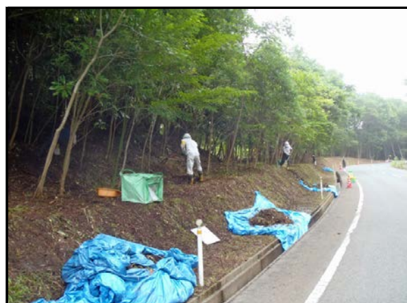
道路路肩除染作業 (H25当時)
