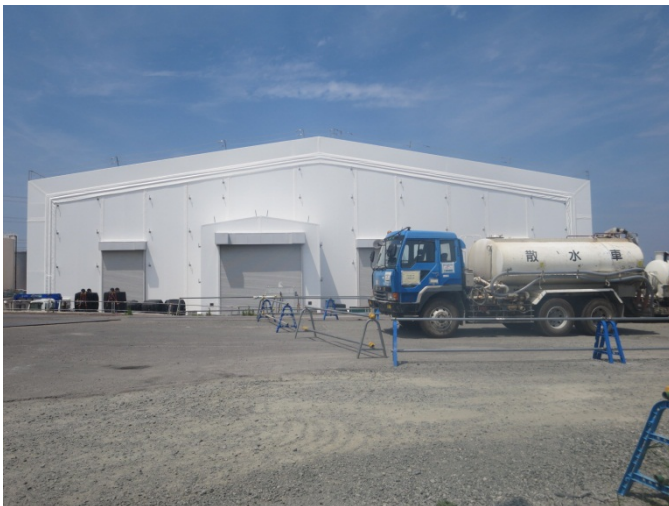
多核種除去設備
